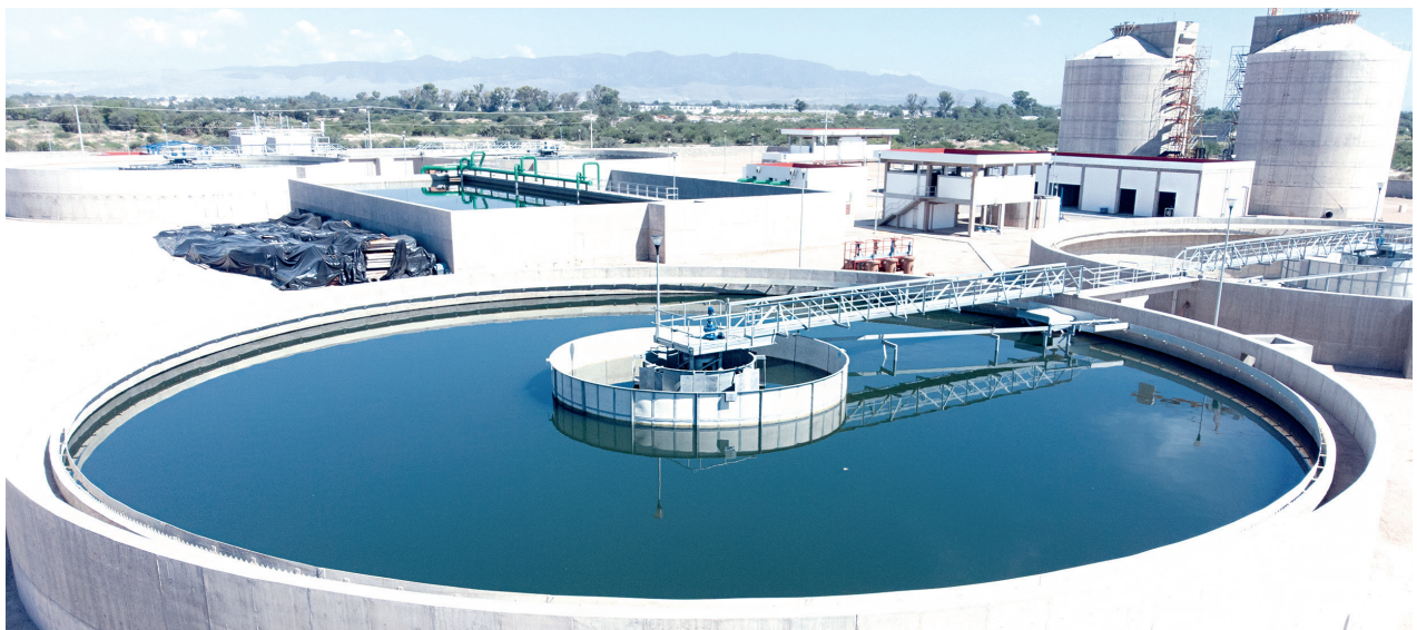
Planta de tratamiento de aguas residuales El Morro.
