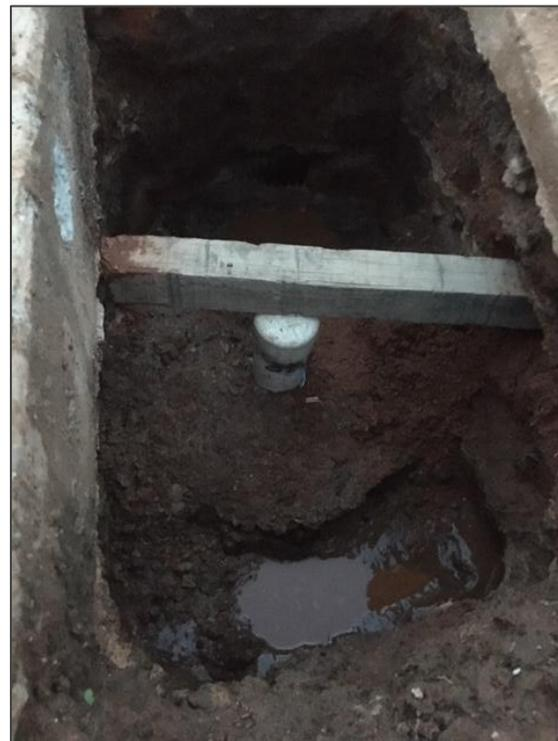
Se recibió el reporte de una fuga muy fuerte en la Calle Constitución en la MM2, ya que un vehículo había roto un hidrante, por lo que se tenía una fuga en la tubería de 3". Se retiró el hidrante y se taponeó el disparo, apuntalándolo con un polín, posteriormente atracando el tapón con concreto
