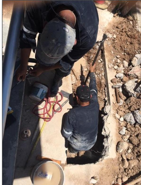
**Se hizo la reparación de varias fugas en la banquetta en la esquina de Av. del Parque con Circuito Tequisquiapam, por lo que finalmente se sustituyeron 8.4 metros de tubería de 4”.**
