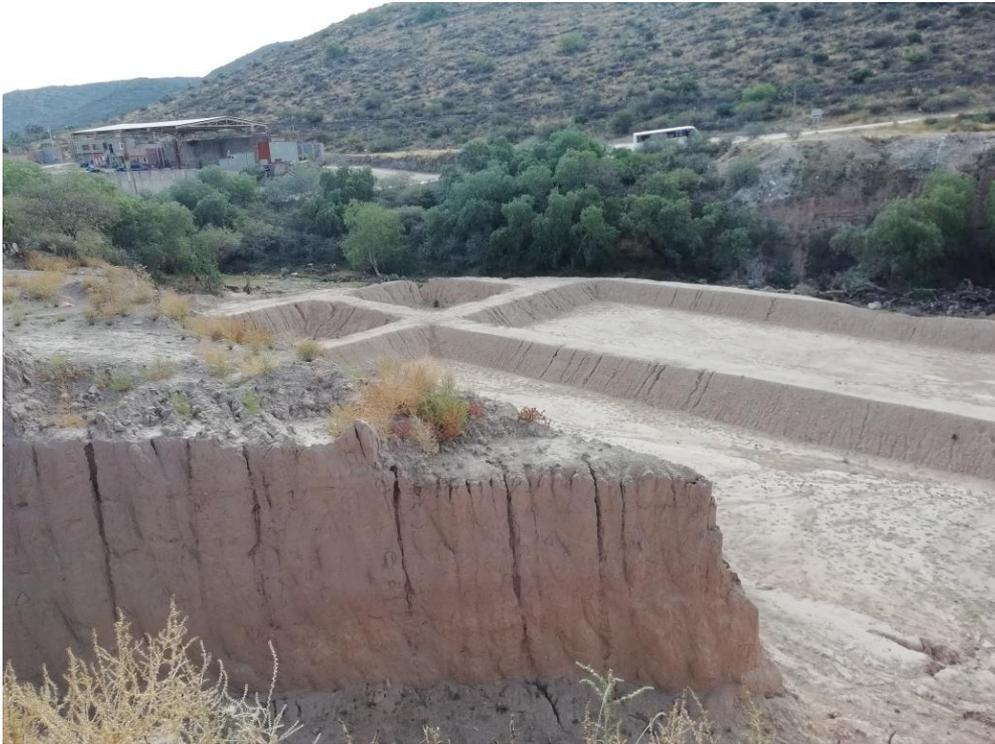
La Construcción de la PTAR se encuentra en la 1° etapa: trabajos de excavación y conformación de terraplenes de tratamiento de lagunas.
