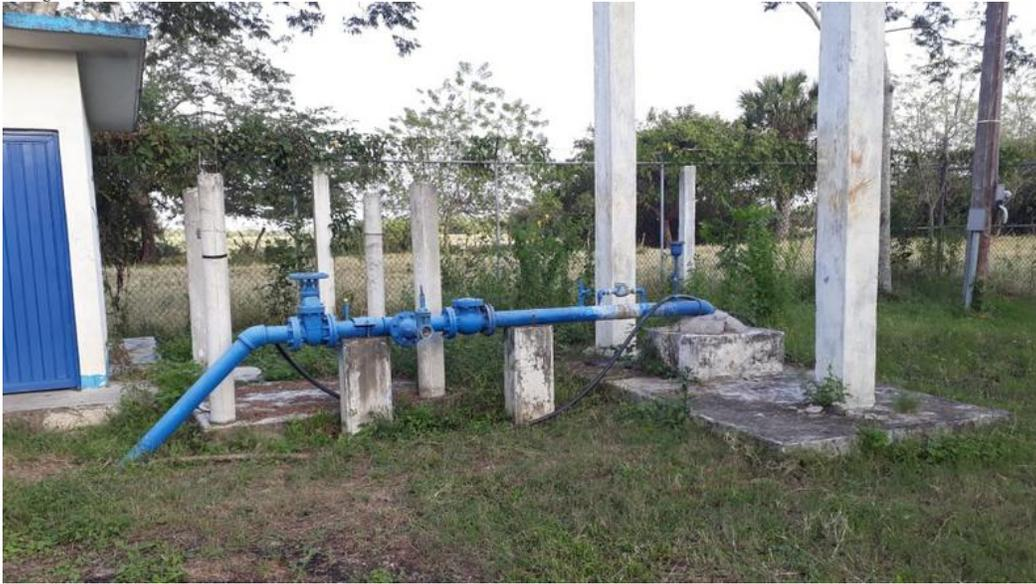
**POZO "LA ESPERANZA" (AGUA POTABLE) LOCALIZACION: 14 Q, X.- 543624, Y.- 2400615, PROF. 18 m, N. E. 10 m, BOMBA ELECTRICA SUMERGIBLE CON TUBERIA DE DESCARGA DE 4", Q. 13 LPS (ANEXO 5)**
